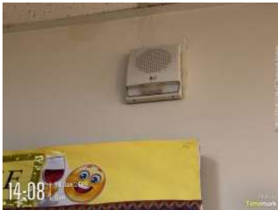
รูปที่ 5.7 ลำโพงแจ้งเตือนเมื่อเกิดเพลิงไหม้
