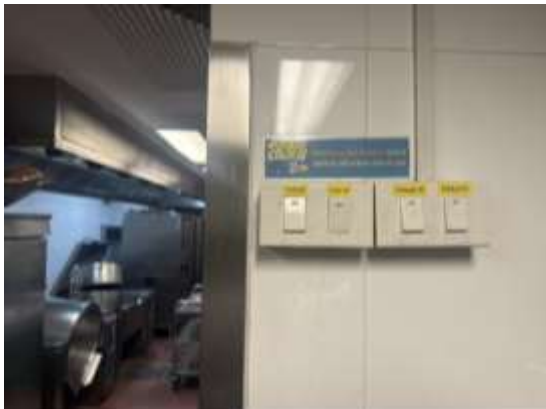
รูปที่ 9.1 ติดตั้งสวิตช์เปิด-ปิดตัวดูดอากาศ ภายในครัว
