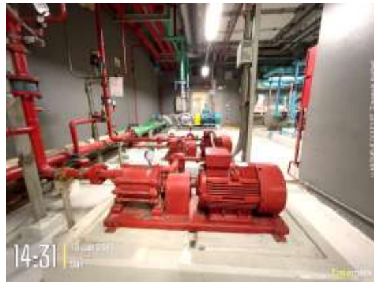
รูปที่ 5.20 เครื่องปั้มน้ำ (Jockey Pump)
