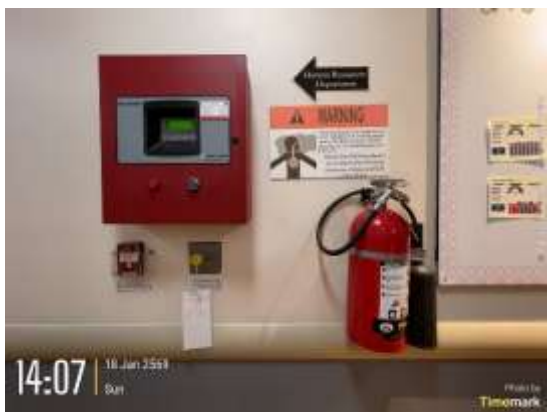
รูปที่ 5.3 อุปกรณ์เตือนภัยและดับเพลิงแบบมือถือ
