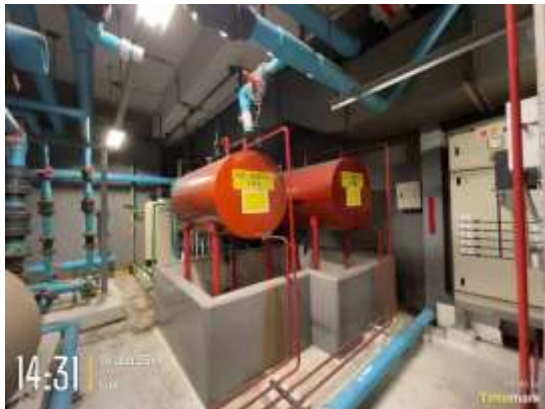
รูปที่ 5.21 ถังเก็บน้ำมันดีเซล
