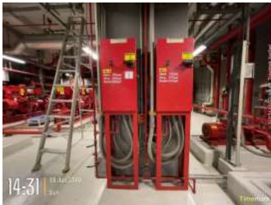
รูปที่ 5.19 ชุดตู้ Control Jockey Pump
