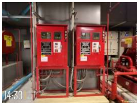
รูปที่ 5.17 ชุดตู้ Control Fire Pump
