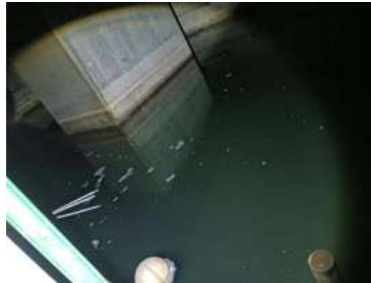
รูปที่ 12.4 การตรวจเช็คการสำรองน้ำดับเพลิง
