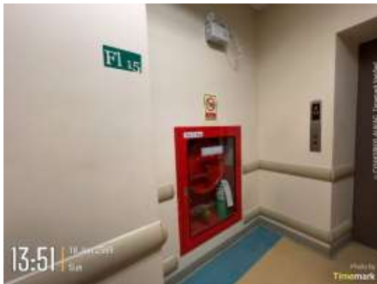
รูปที่ 5.10 อุปกรณ์ดับเพลิงแบบสวมเร็ว
