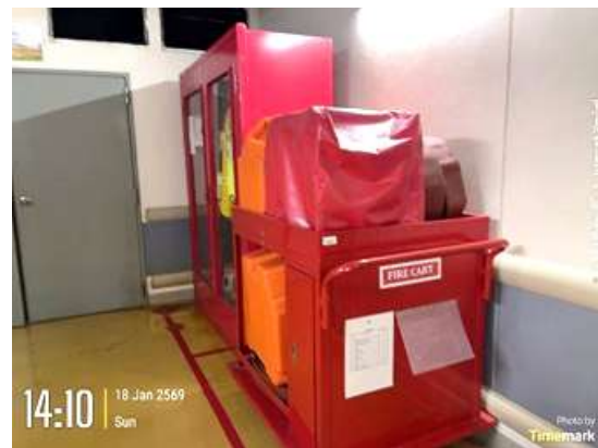
รูปที่ 5.14 ตู้เก็บอุปกรณ์ดับเพลิงมีล้อเลื่อน
